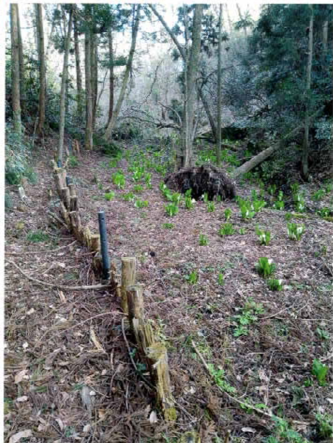
実施前 現地確認 2023.3 NO2
