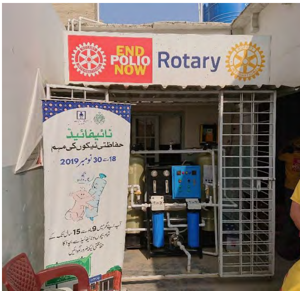
ソーラー発電、高性能フィルターで地下水を浄化。
